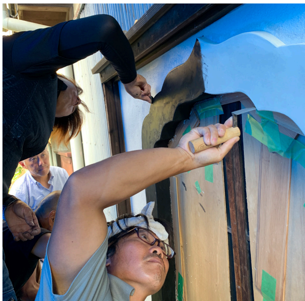
最近では珍しくなったお寺の火灯窓を塗る作業
