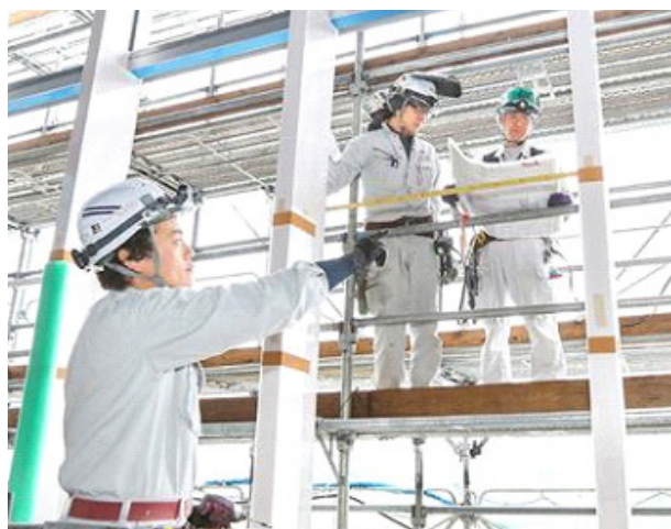
安全を十分確保しながら高所作業
